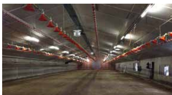
AVANT - Éclairage de tubes fluorescents
