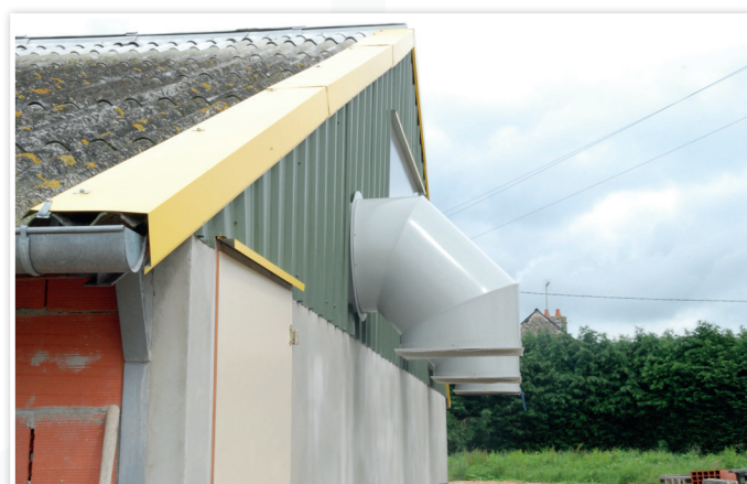
Coude d'entrée d'air en situation
